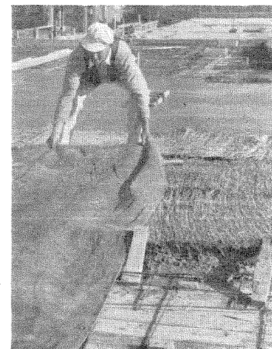
Fig. 17. Tildækning af nyudstøbt beton med halmmåtter og presemeninger.
