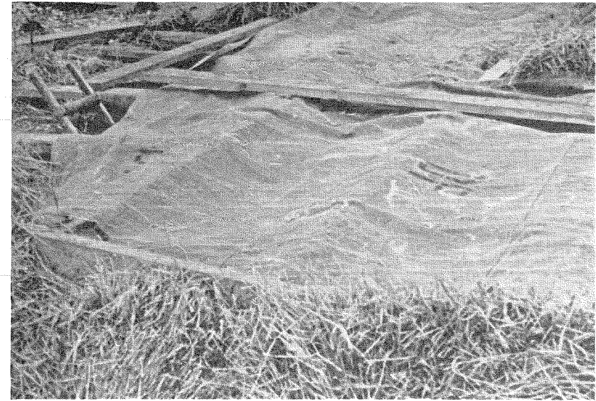
Fig. 2. Byggegrube overdækket med presenninger. Jorden er isoleret med halm.
